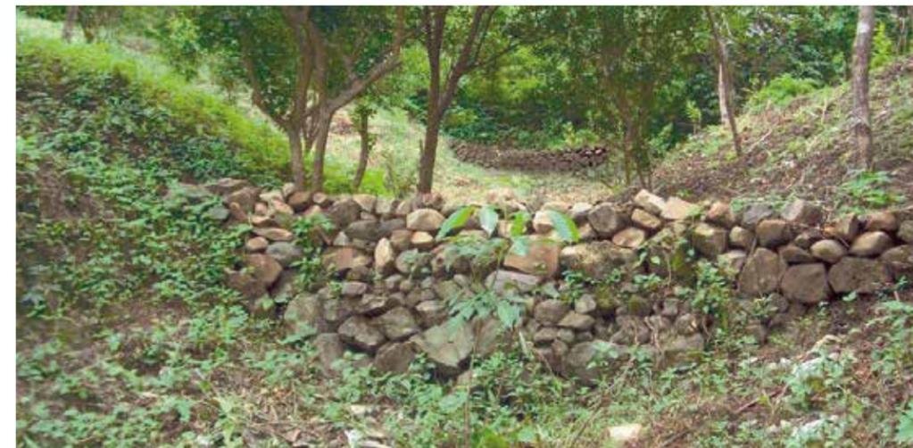
Batería de diques de infiltración
