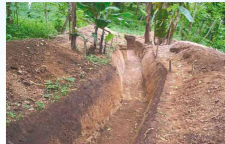
Zanja de almacenamiento y conducción de agua
